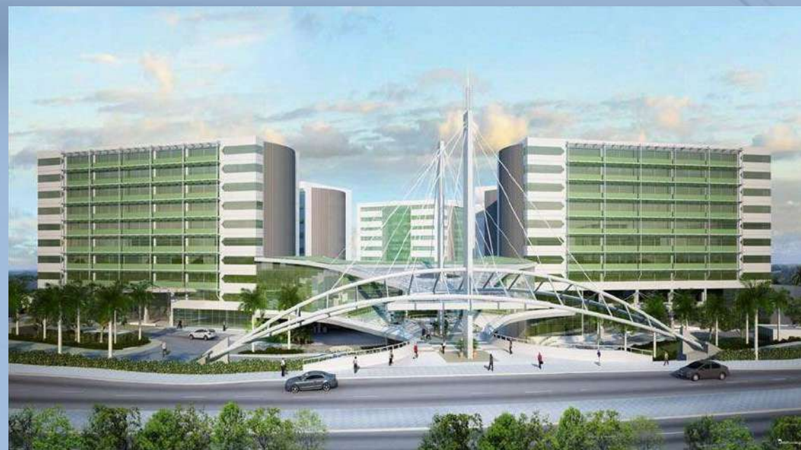
Escritório - Hangar Business Park
