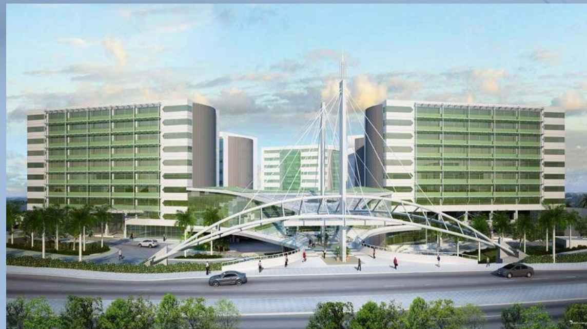
Escritório - Hangar Business Park
